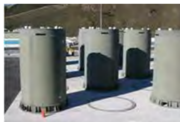
アメリカのドライキャスクの使用済み燃料貯蔵
