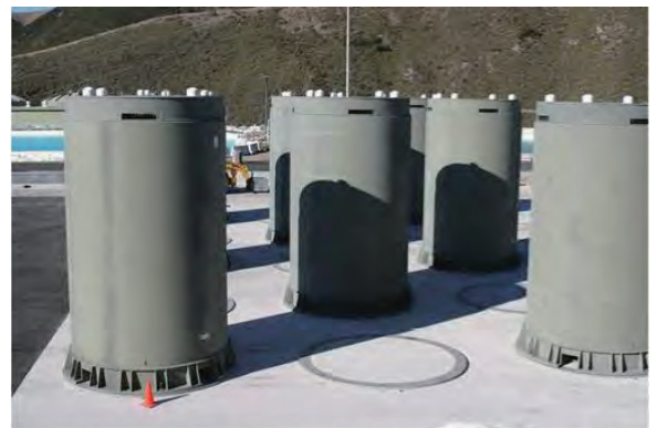
アメリカのドライキャスクの使用済み燃料貯蔵
