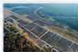
ドイツ東部フランクフルトの軍用飛行場跡地で建設が進む太陽光発電施設＝2011年11月25日撮影（EPA＝時事）
