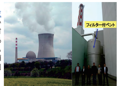
図5 ライブシュタット発電所とフィルター付ベント
