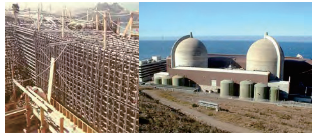
図1 強固な鉄筋基礎、図2完成した発電所
